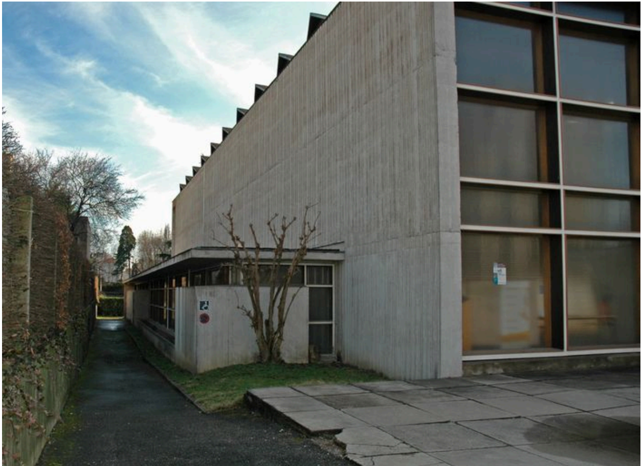
Élévation latérale est et bas-côté depuis le nord
