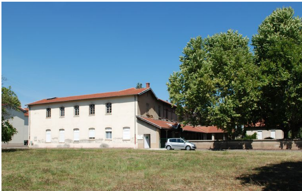
Bâtiment 456-457, aile sud, façade sud
