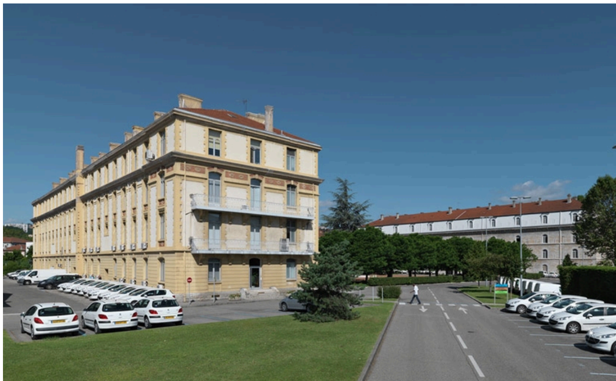
Pignon nord est du bâtiment de 1916.
