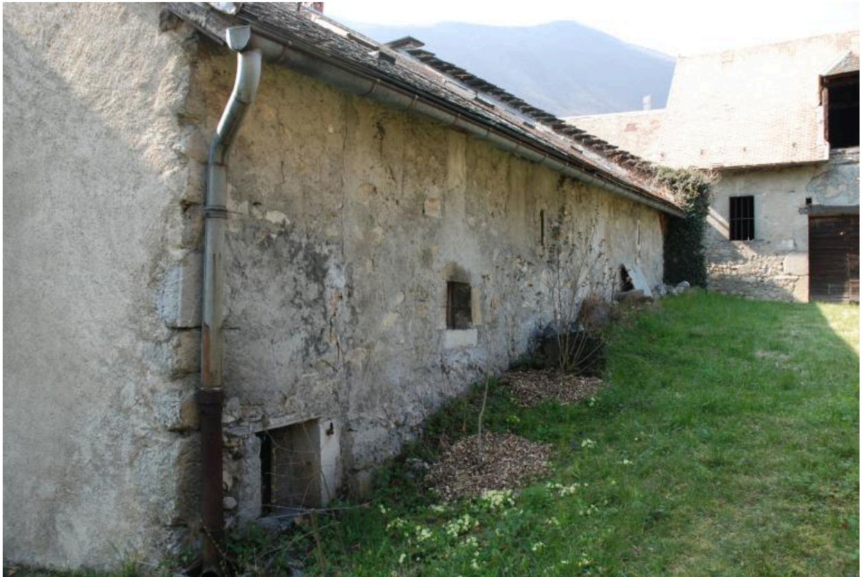
Façade arrière du corps de bâtiment est (orientée à l'est)
