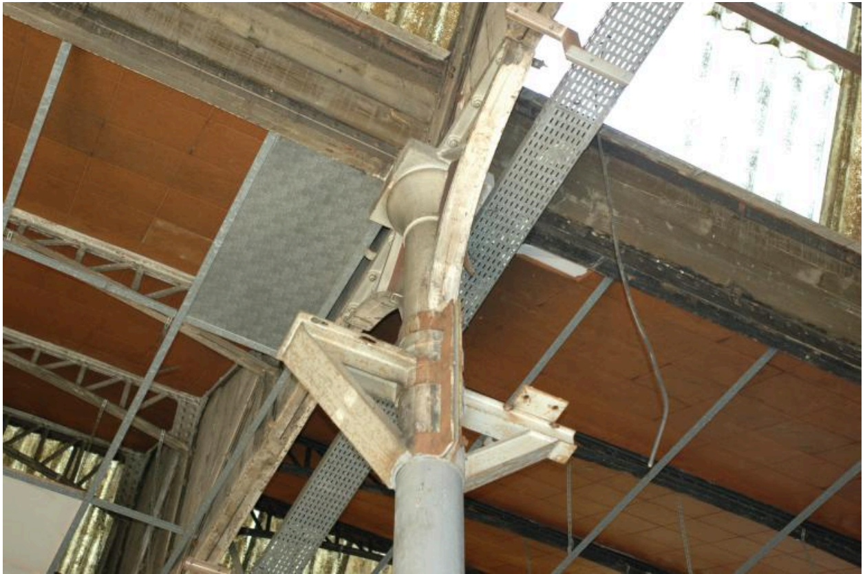
Détail chapiteau poteau fonte
