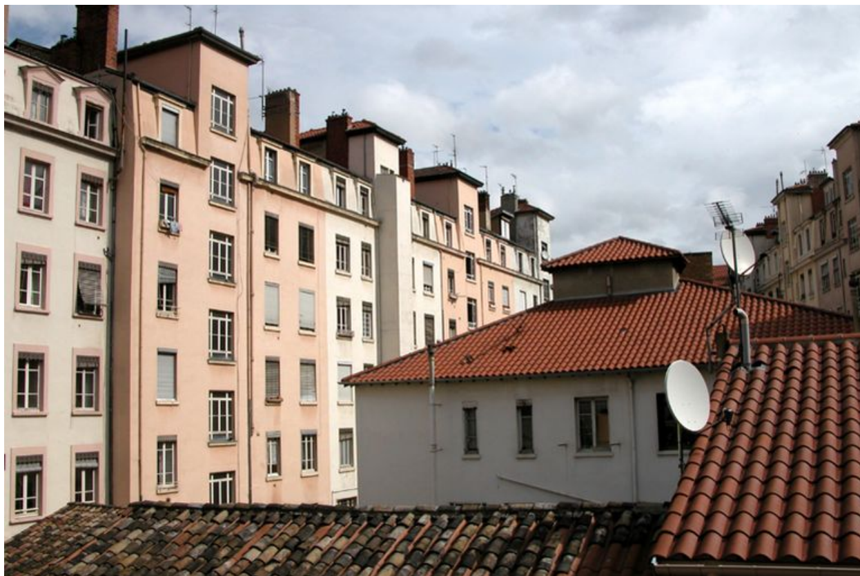
Elévation postérieure depuis un immeuble avenue Jean-Jaurès
