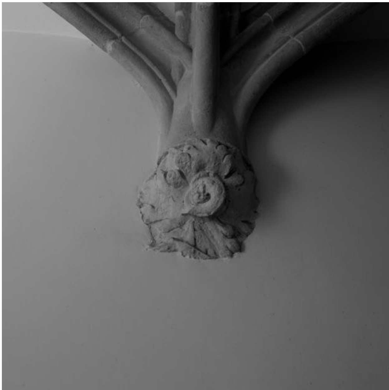
Voûte de l'allée, détail du culot 8
