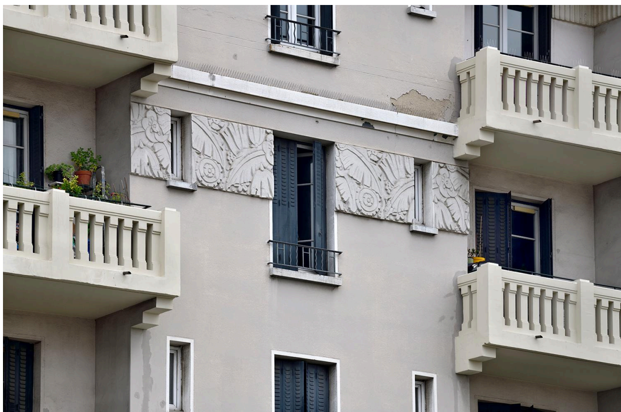
Elévation rue Auguste-Chollat : ornementation des 4e et 5e étages carrés
