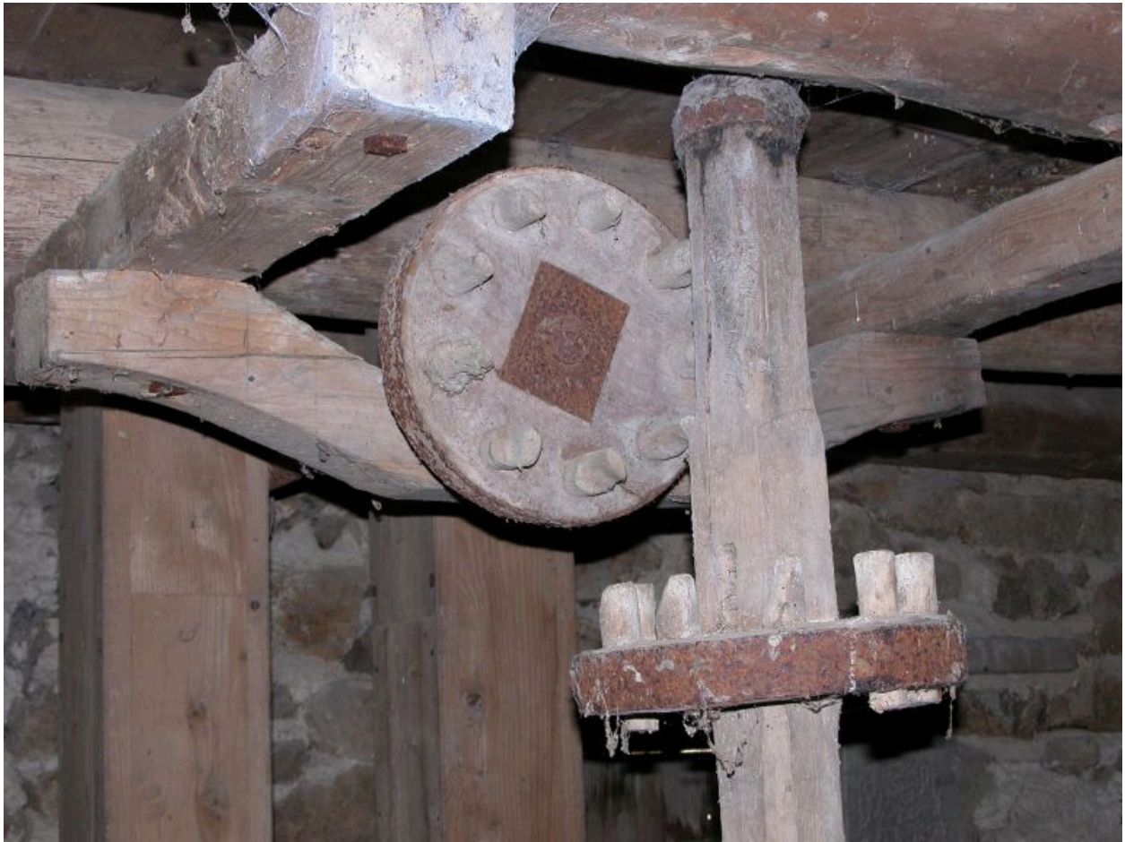
Vue partielle du mécanisme situé au-dessus des meules.
