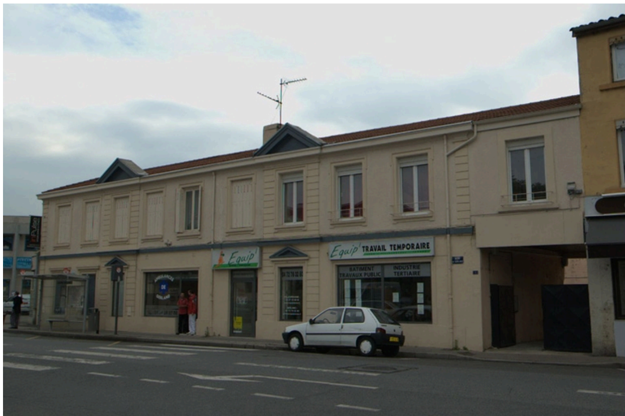
Vue sud-ouest du bâtiment principal
