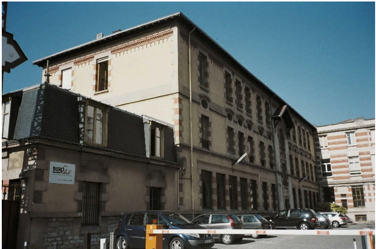
Vue extérieure du bâtiment
