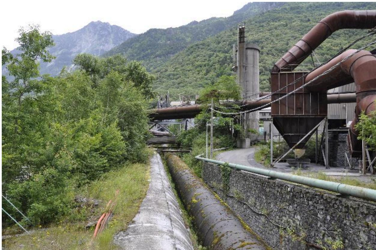
Vue extérieure des conduites forcées en béton et en fonte rivetée
