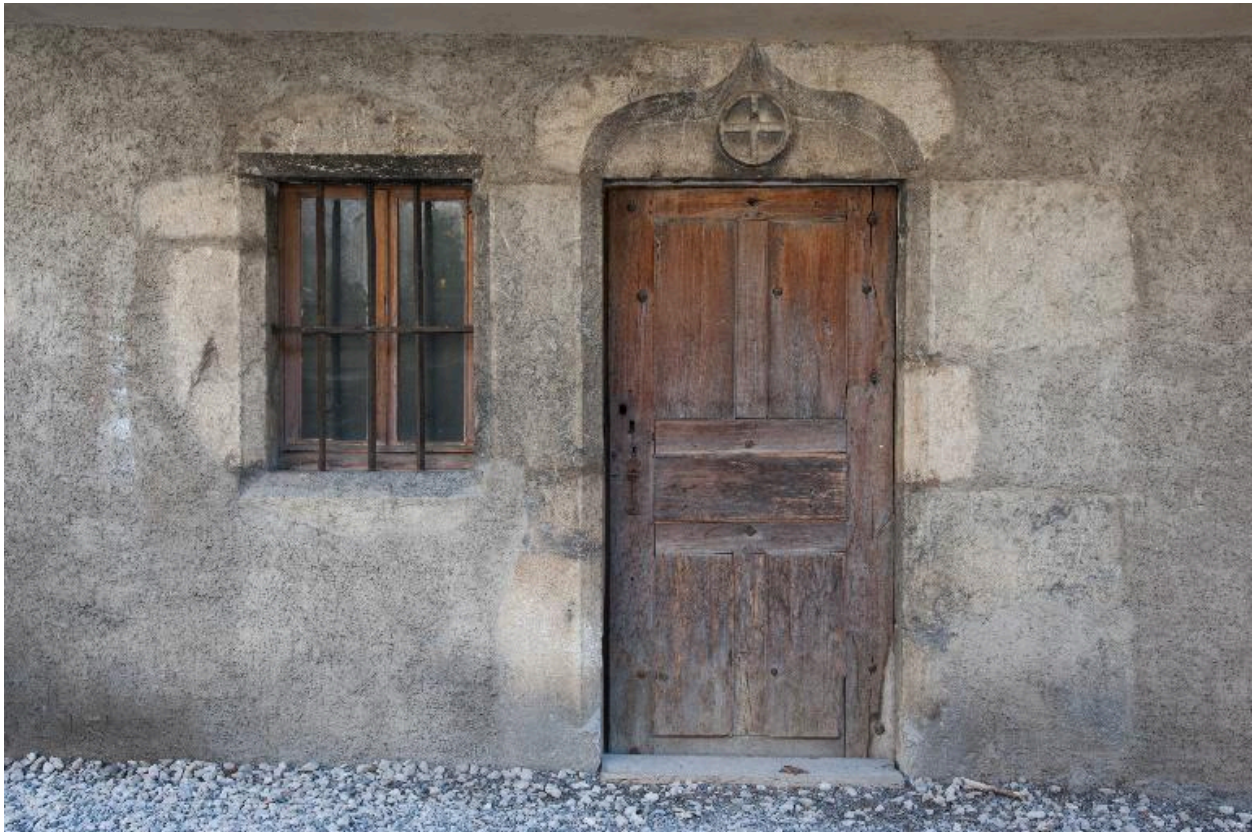
Vue d'un encadrement en accolade avec une croix cerclée.
