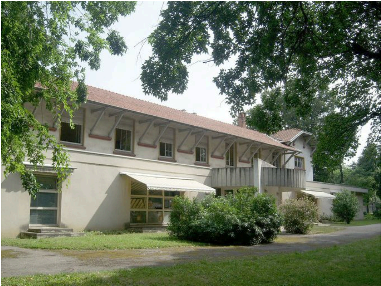
Batiment Nord Ouest, Elevation trois quart gauche
