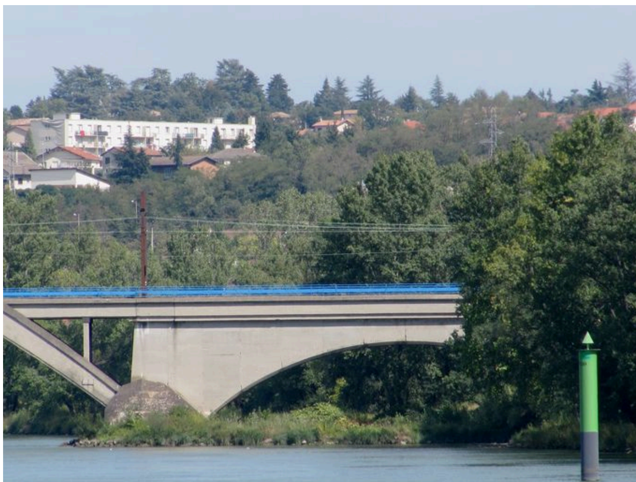
Vue de la travée rive gauche, face aval
