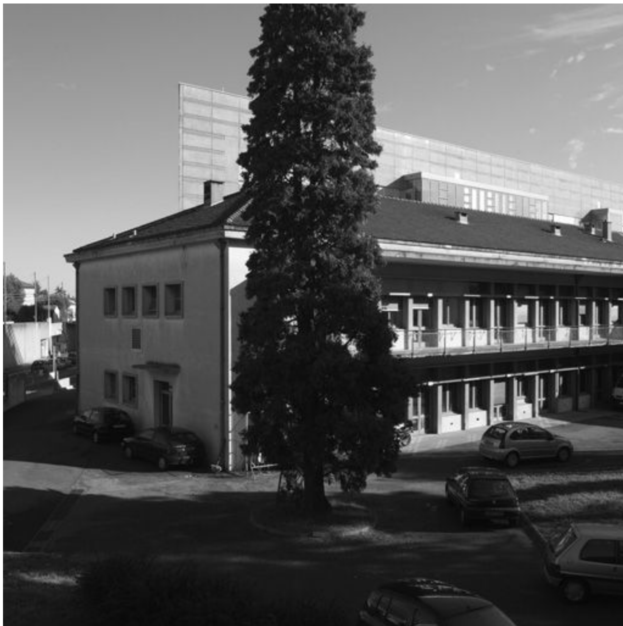
Bâtiment W, aile nord, élévation sur la cour ouest
