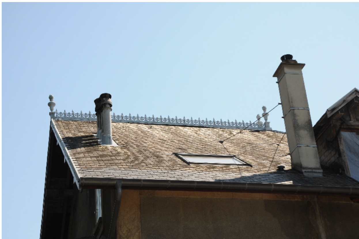
Détail sur la crête et les épis de faîtage en zinc
