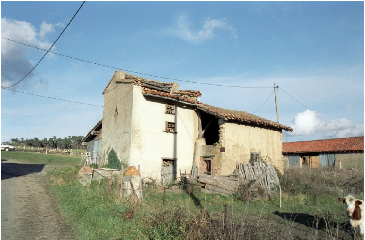
Colombier à Saint-Sixte, la Treille (1987 B1 484), type I. Façade antérieure.
