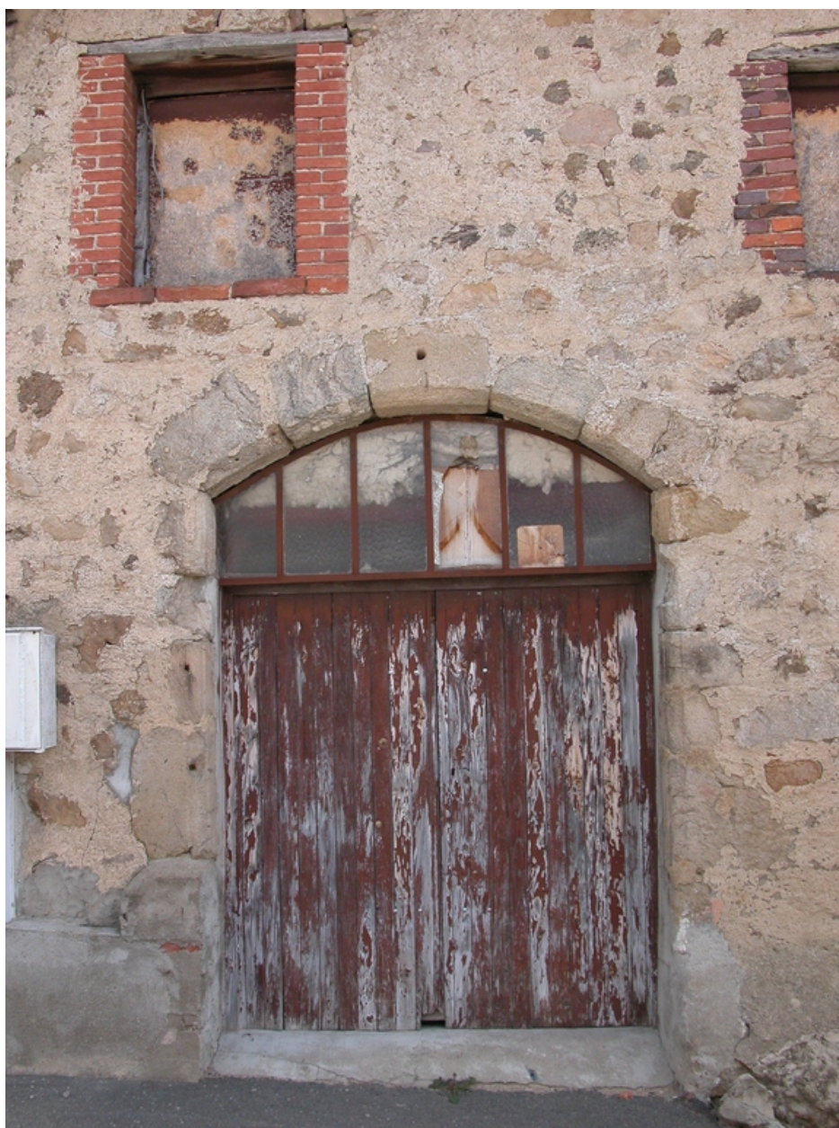
Détail de la porte de la remise.
