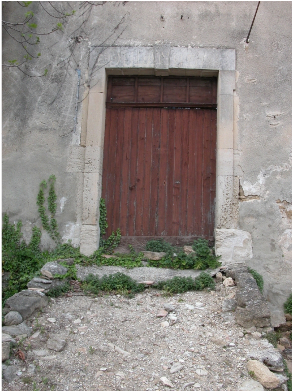
Place de l'Eglise, détail de l'élévation sud-est : entrée de l'ancienne boulangerie, avec enseigne peinte au-dessus de la porte (1 rue des Commerçants : boulangerie, café et ferme).
