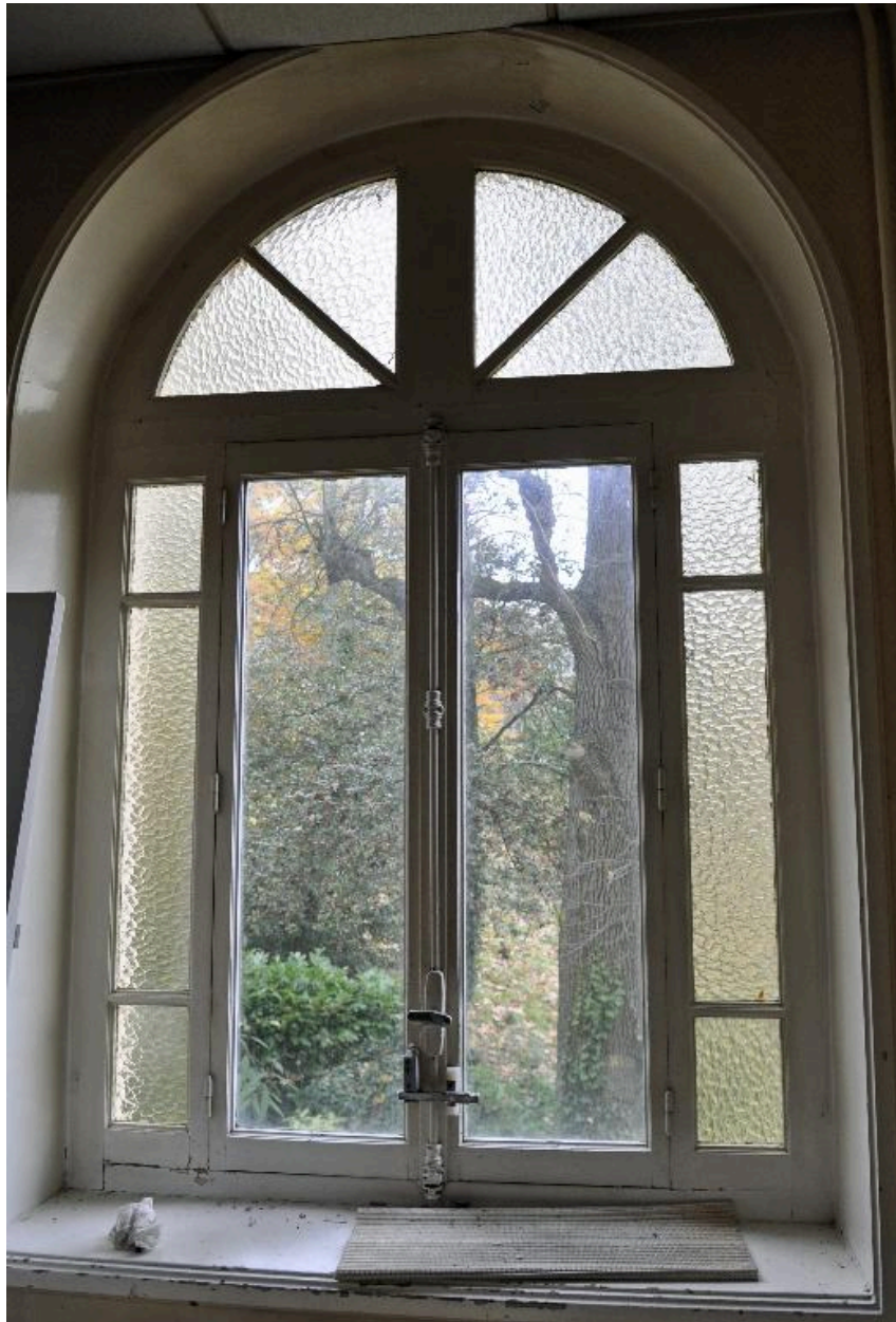
Bâtiment nord, élévation ouest : vue intérieure d'une fenêtre en plein cintre avec menuiserie en bois
