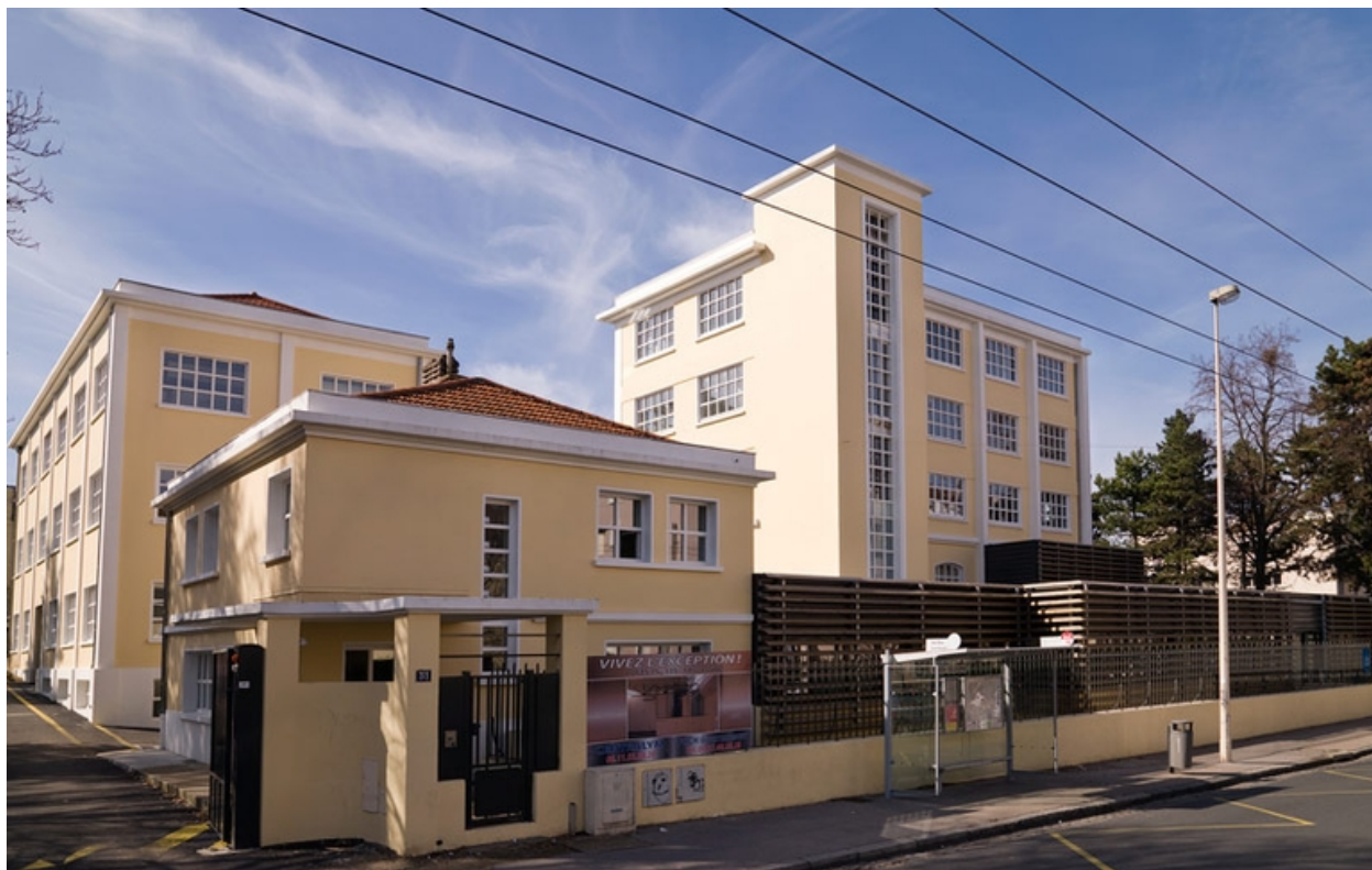
Batiment réhabilité, vue ouest
