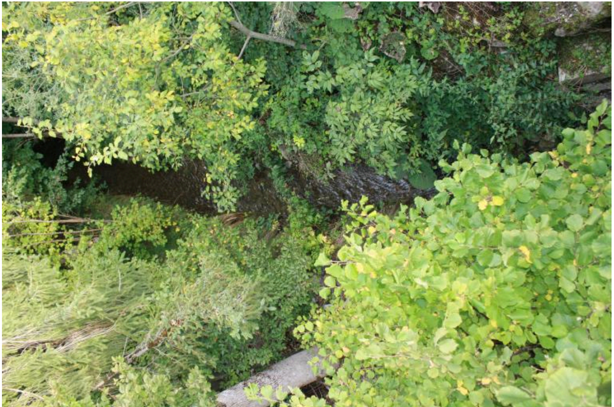
Ponceau de la Glière, canal Martin
