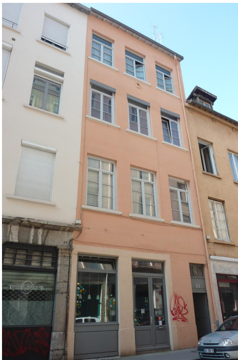
Vue d'ensemble de l'immeuble atelier
