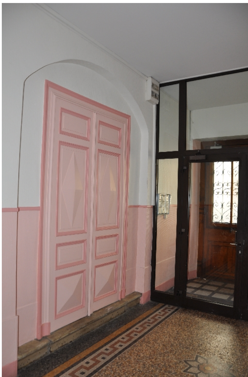
Porte dans le hall d'entrée
