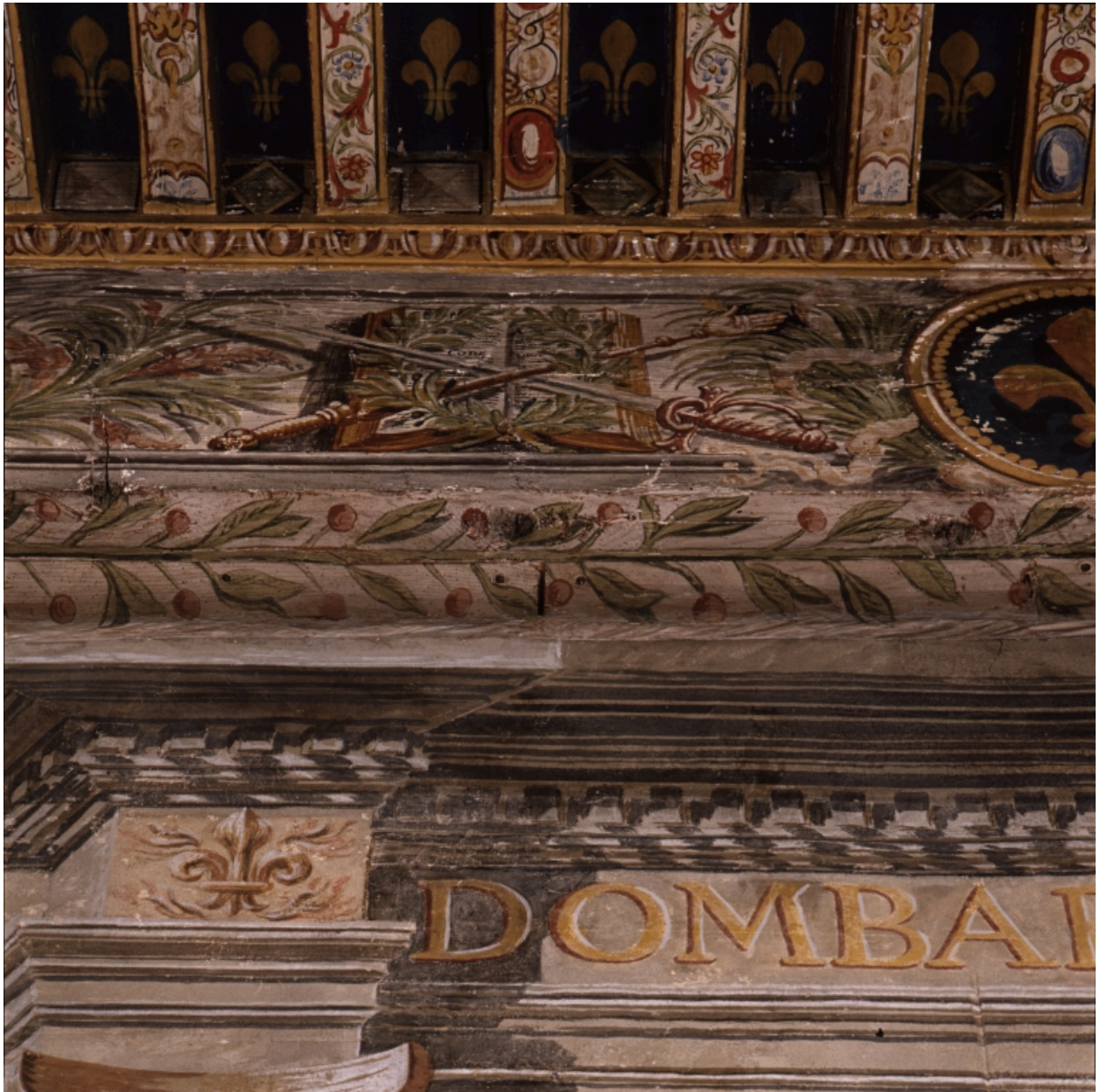
Poutre 1 : détail du décor de la face inférieure (au centre).
