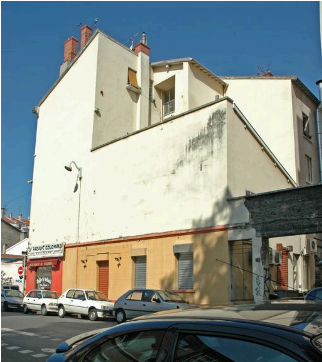
Elévation rue de Créqui depuis le nord-est
