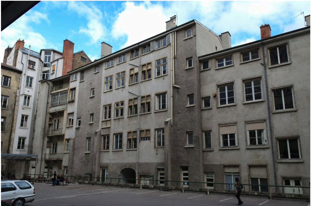
Elévation postérieure, vue partielle depuis le sud
