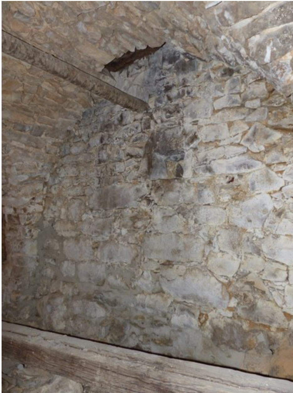
Etage de soubassement, étable. Mur sud, travée ouest. Niche et trappe d'abat-foin.
