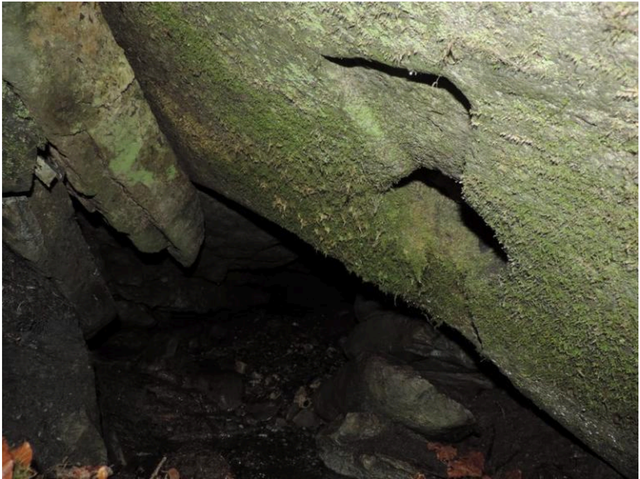
Meule à farine de dessus visible dans les décombres du bâtiment (cliché : S.Santon).
