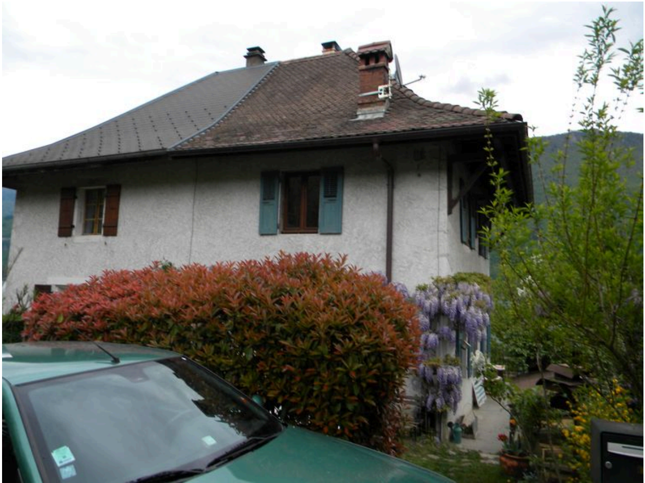
Vue de la façade est avec l'entrée principale.
