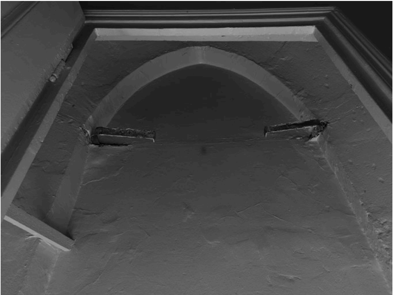
Bâtiment R. 1er étage. Pièce est. Porte en arc brisé transformée en placard
