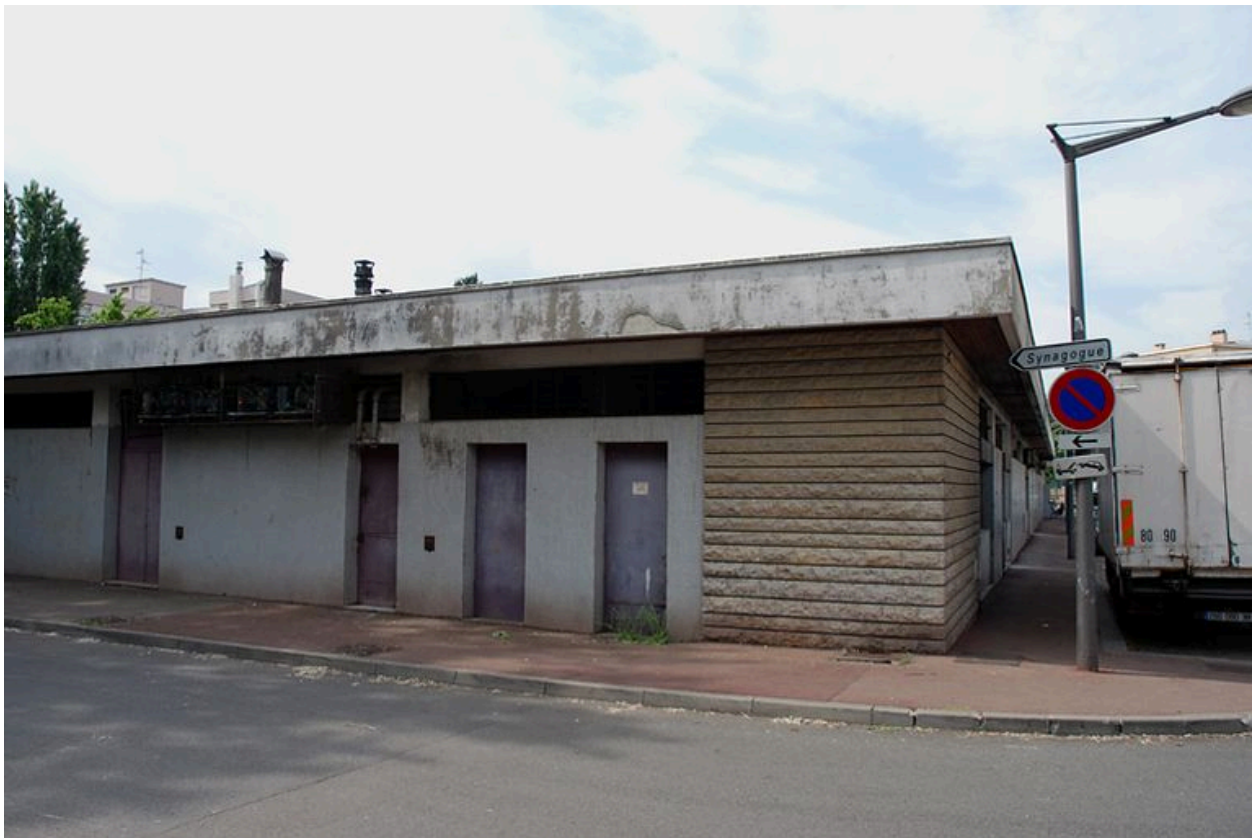
Elévation postérieure Sud-Ouest
