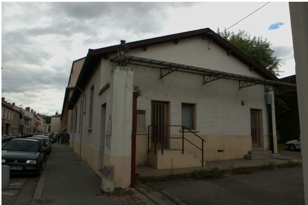
Pavillon d'entrée avec verrière, vue nord-ouest
