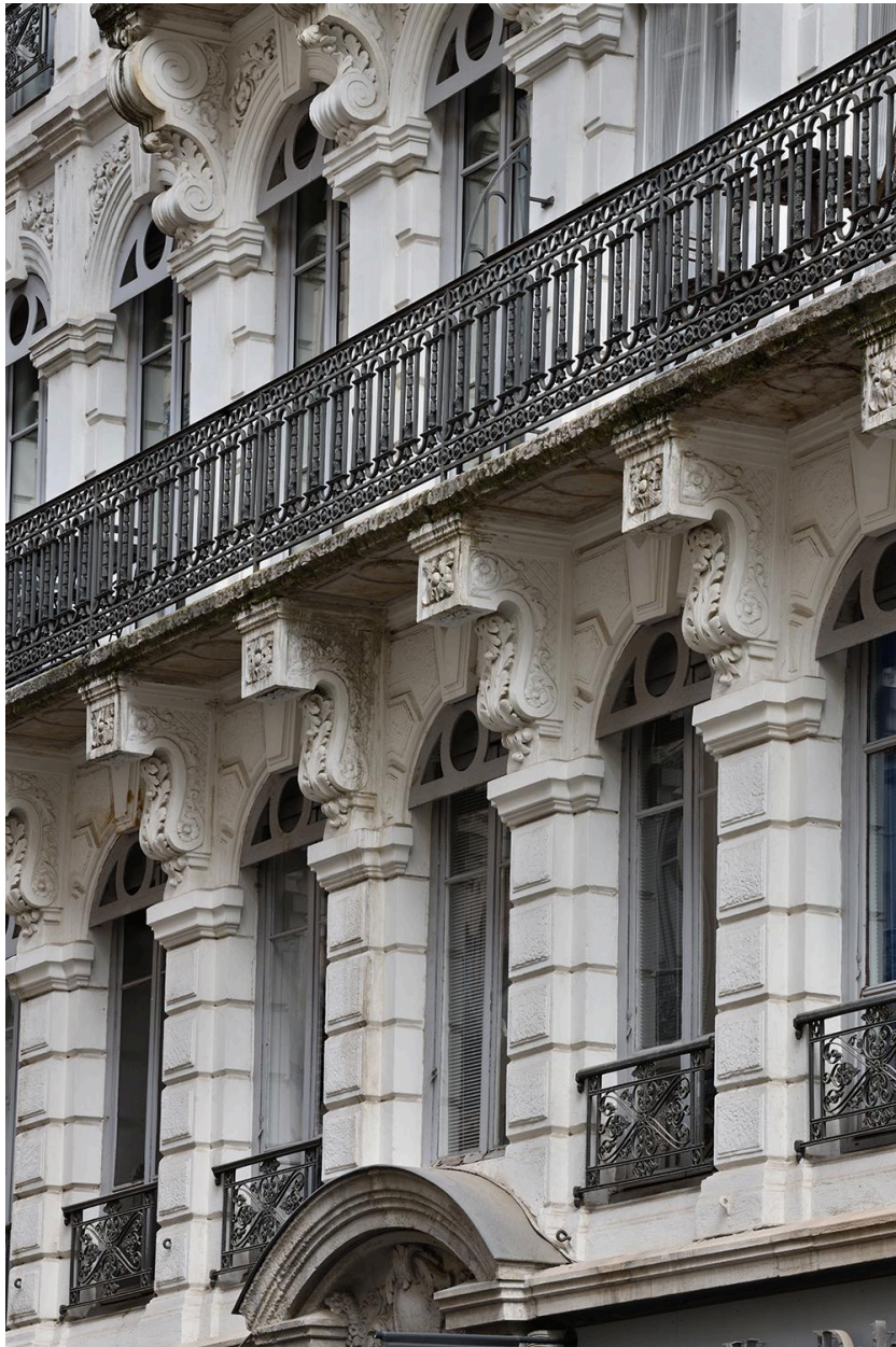
Consoles soutenant le balcon du deuxième étage carré
