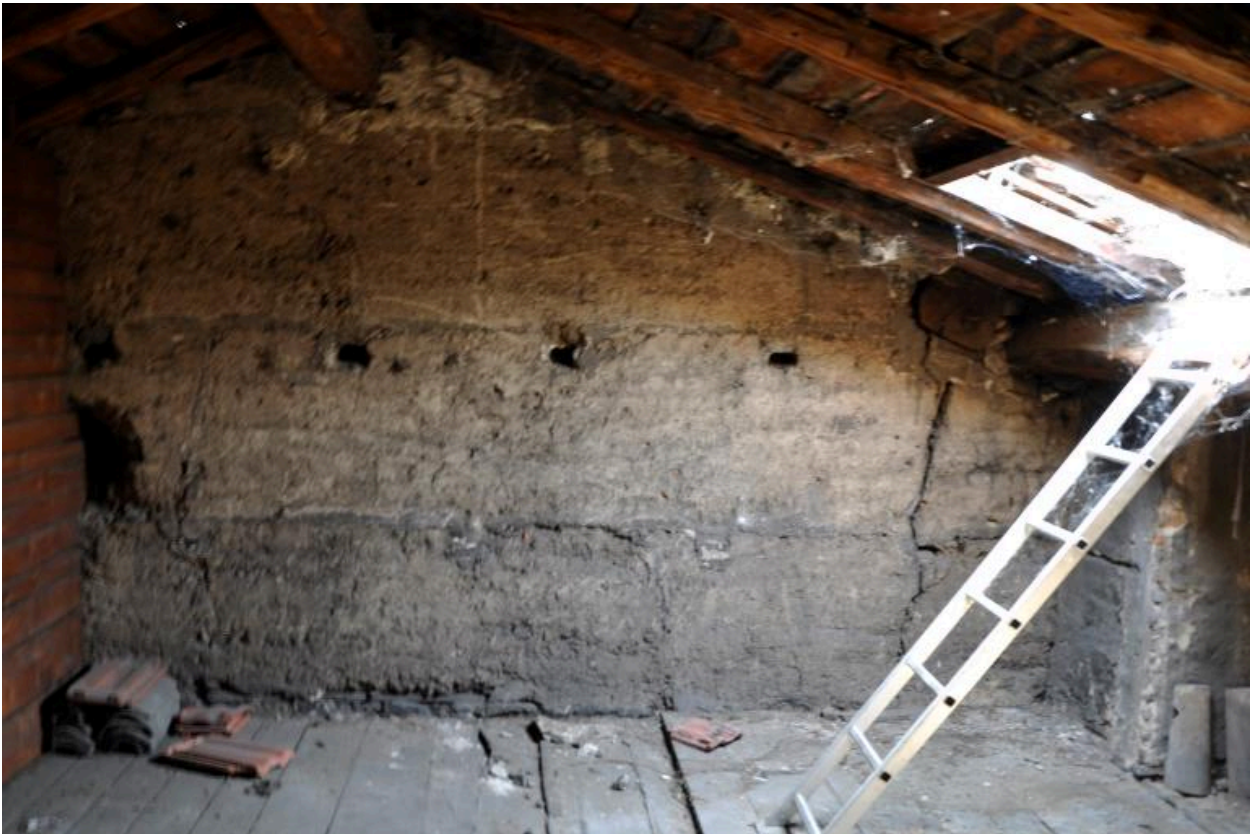
Vue de l'étage de comble, mur pignon en pisé
