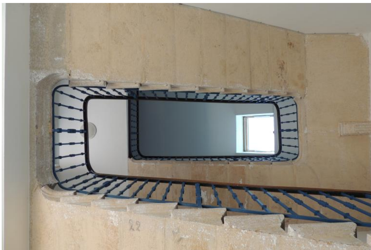
Escalier intérieur depuis le rez-de-chaussée.
