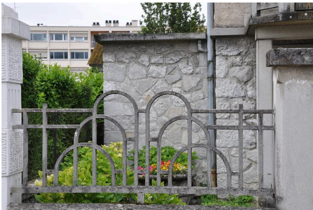
Détail de la barrière en ciment moulé
