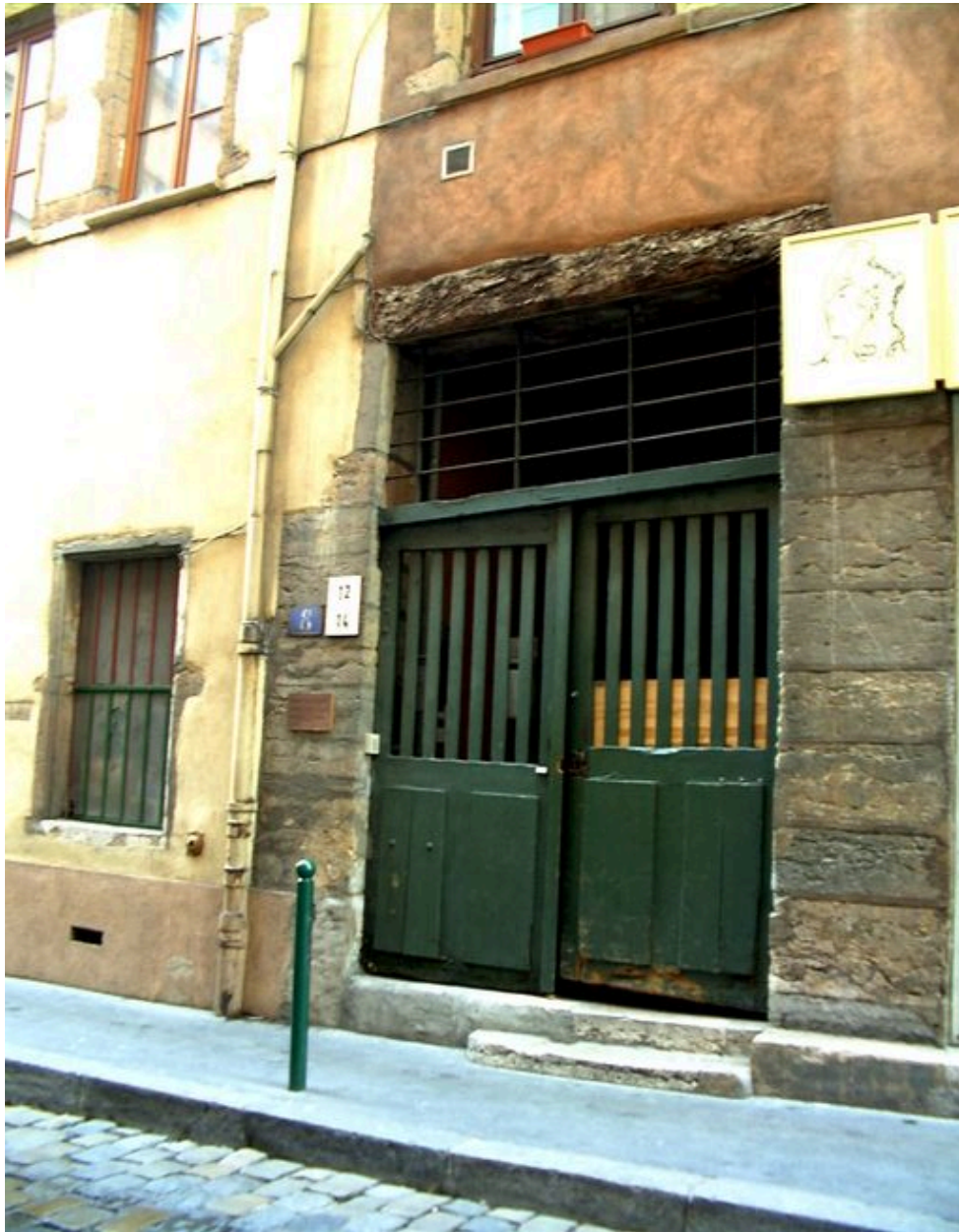
Porte d'entrée rue du Doyenné
