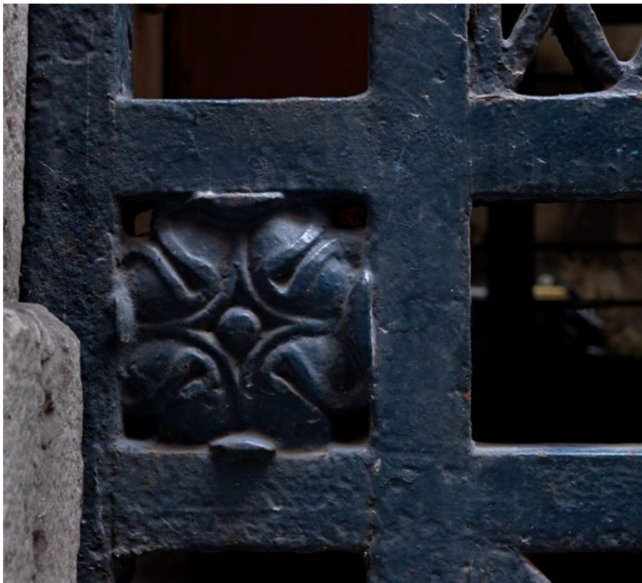
Porte bâtarde, détail de la grille : un fleuron
