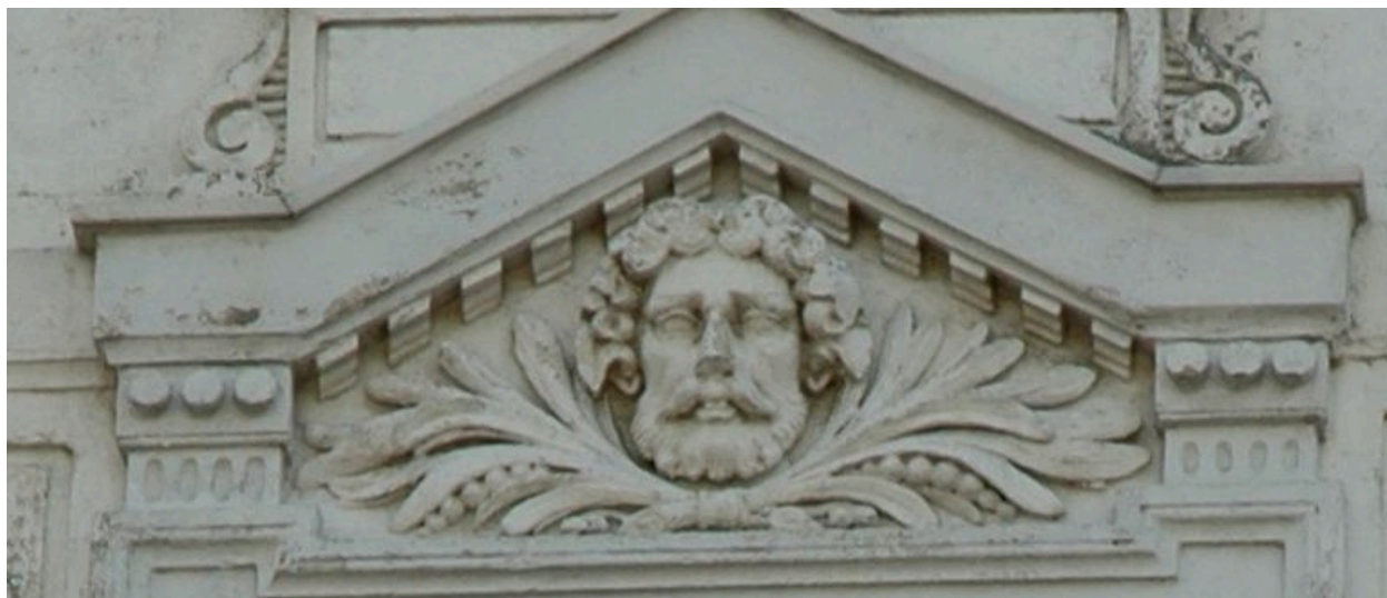
Détail du fronton de la 2e travée, 3e étage
