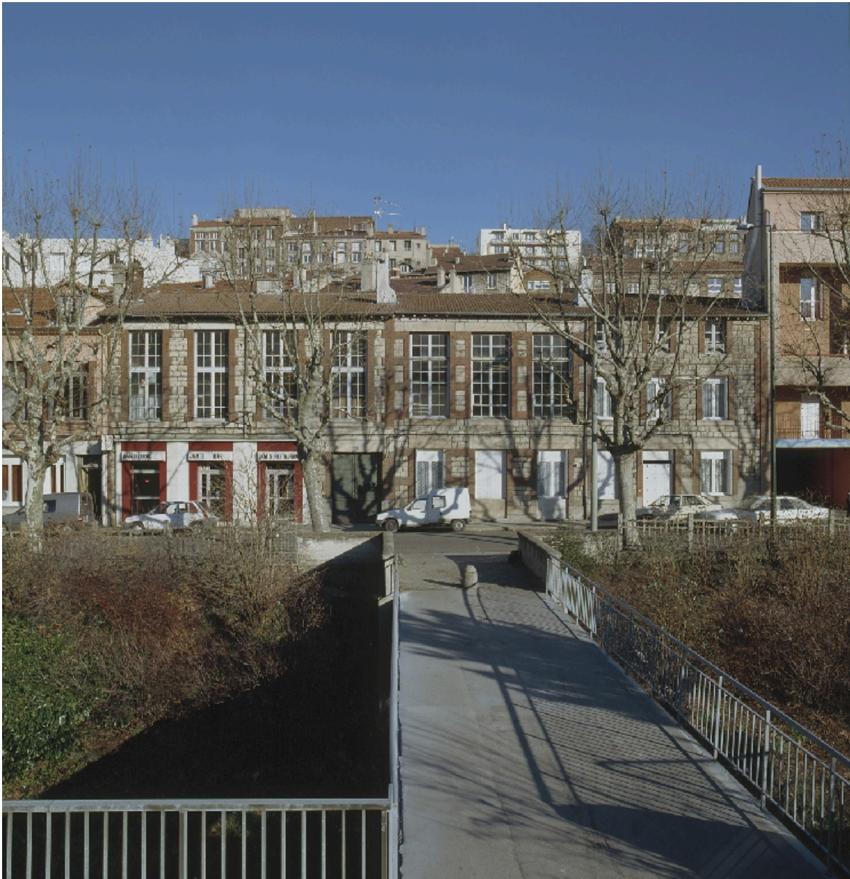
Élévation principale. Au premier plan, passerelle au-dessus de la voie ferrée
