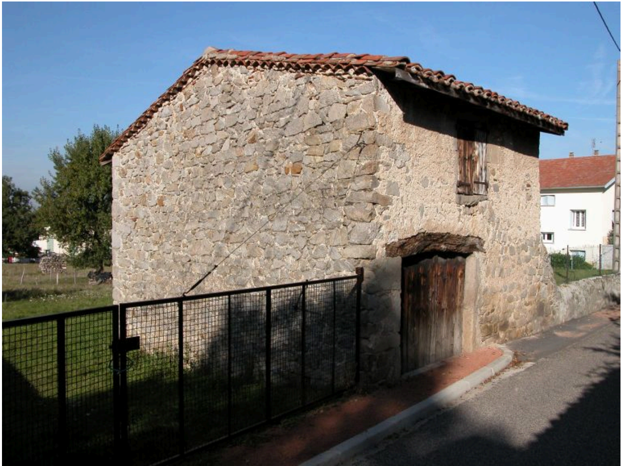
Vue générale latérale gauche
