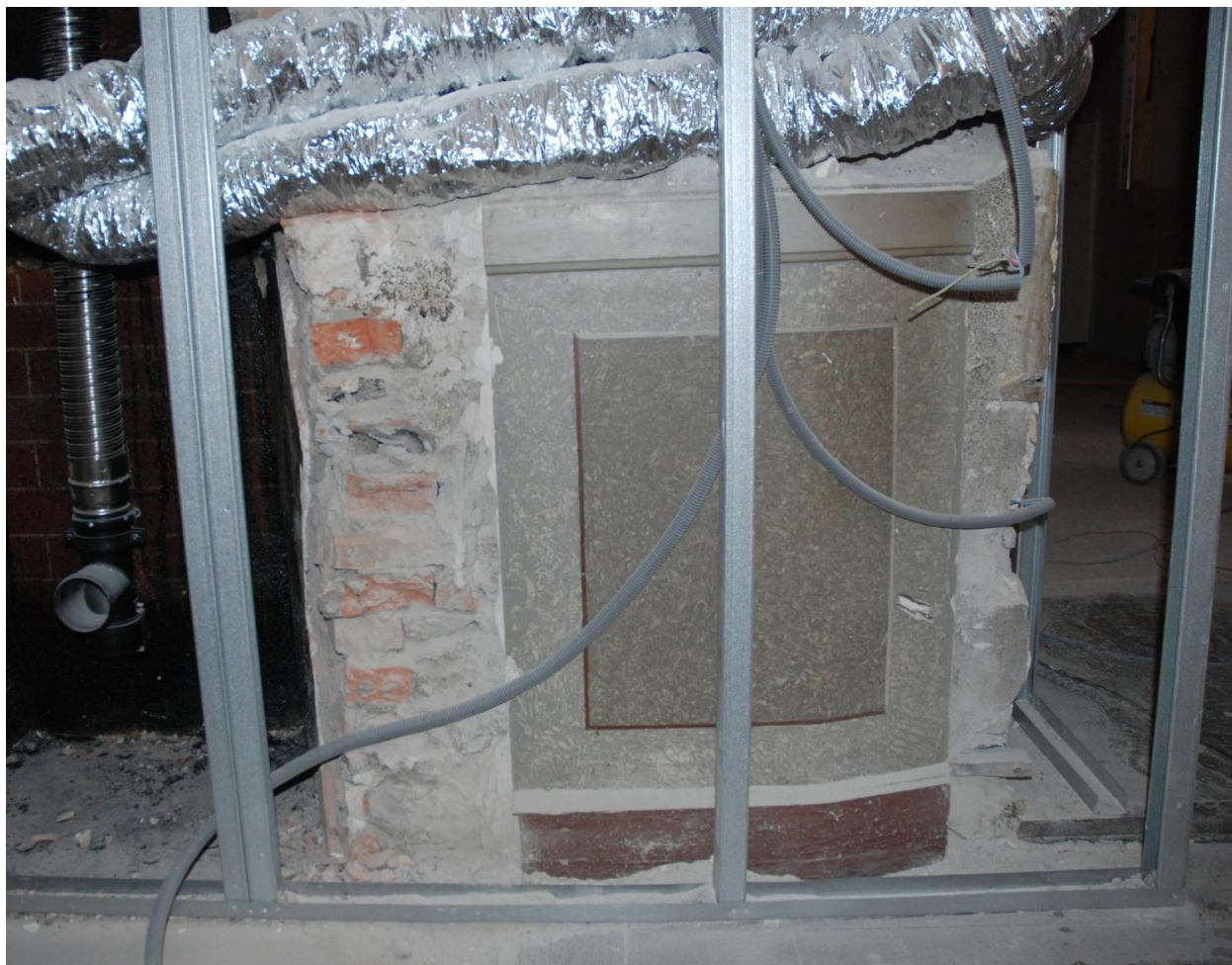
Maison de vigneron (2018 I1 196), vue intérieure, détail : vestiges de décor peint, cheminée.
