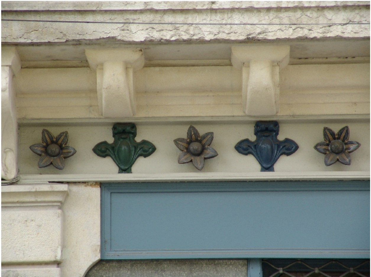
Détail du décor d'une poutrelle métallique
