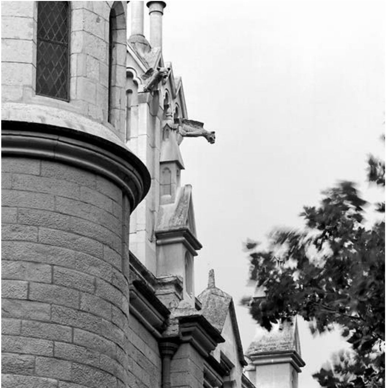
Élévation nord : détail de toiture, gargouille
