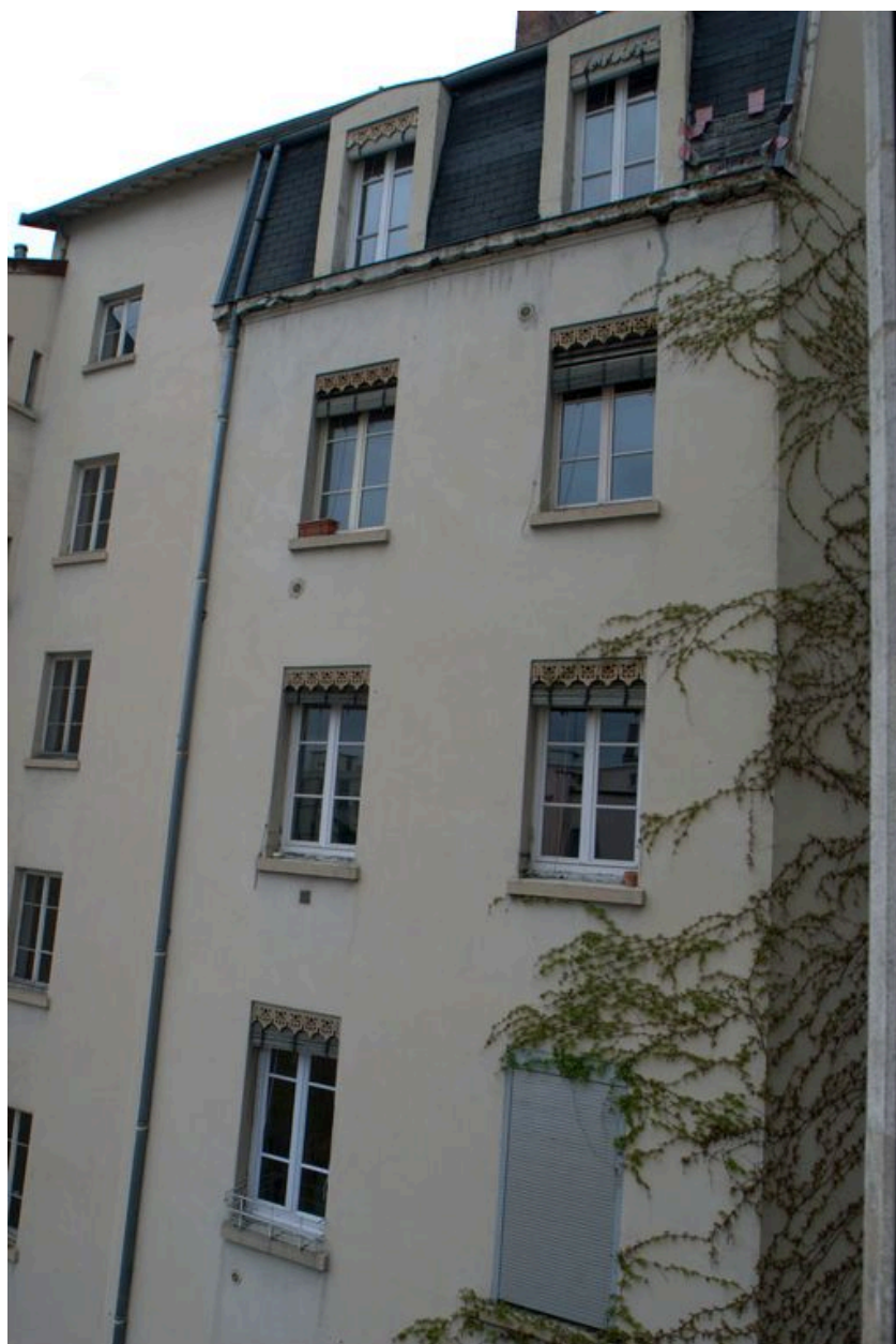
Elévation postérieure, détail
