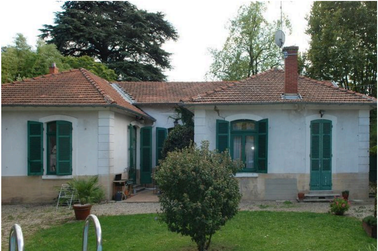
Bâtiment 510, façade postérieure (nord). Les avant-corps latéraux sont des extensions construites vers 1913
