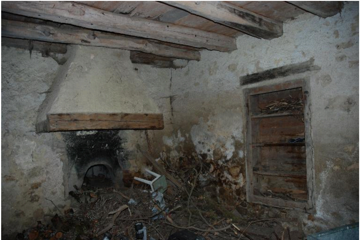
Vue intérieure de la remise : four à pain.
