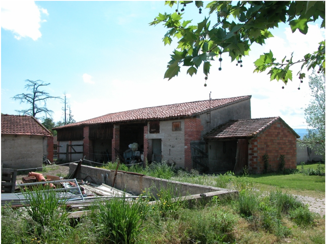
Vue de l'écurie-remise, depuis le sud-ouest.
